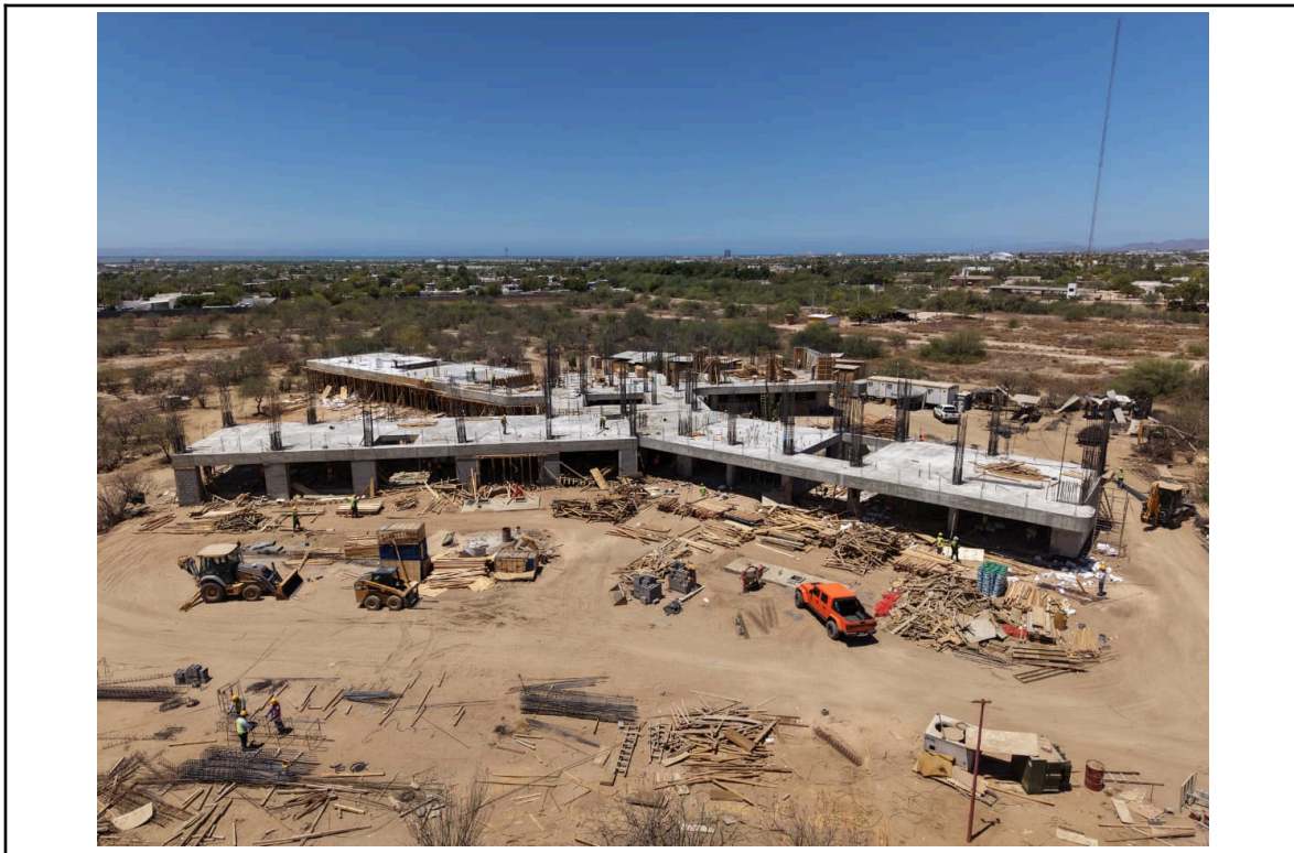
Construcción edificio académico del área de ciencias de la salud en el campus La Paz
