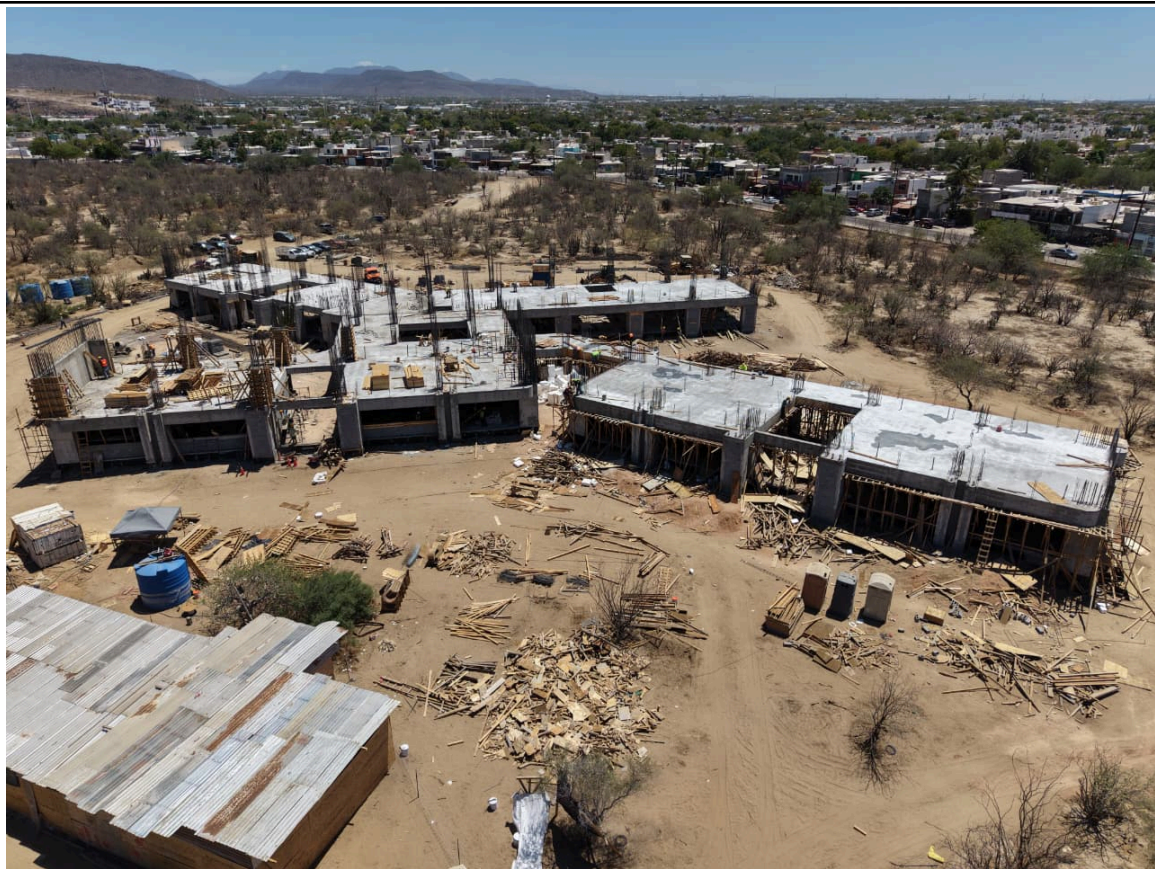
Proceso de construcción vista norte
